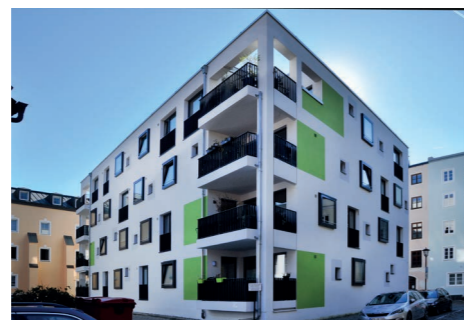
K13 I MEHRFAMILIENHAUS WASSERBURG, (2013-2014)
