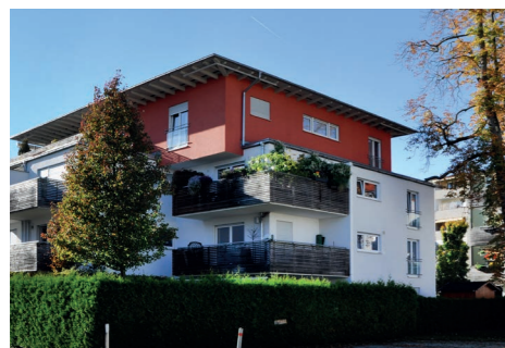
KASTANIENHOF I MEHRFAMILIENHÄUSER ROSENHEIM, 2005-2006
